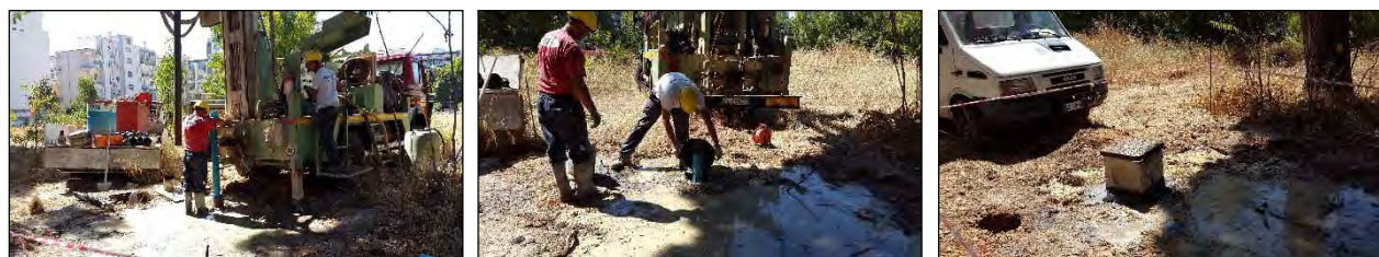
Figura 5 – Realizzazione pozzo PE1, riempimento intercapedine e pozzetto in c.a.v. con chiusino in ghisa
