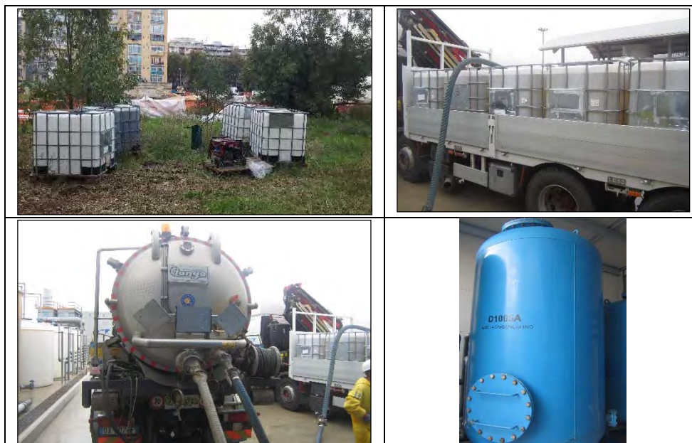
Figura 12 – Campionamento 12 m 3 acqua di falda da PT1 e trasporto all'impianto De Cristofaro
